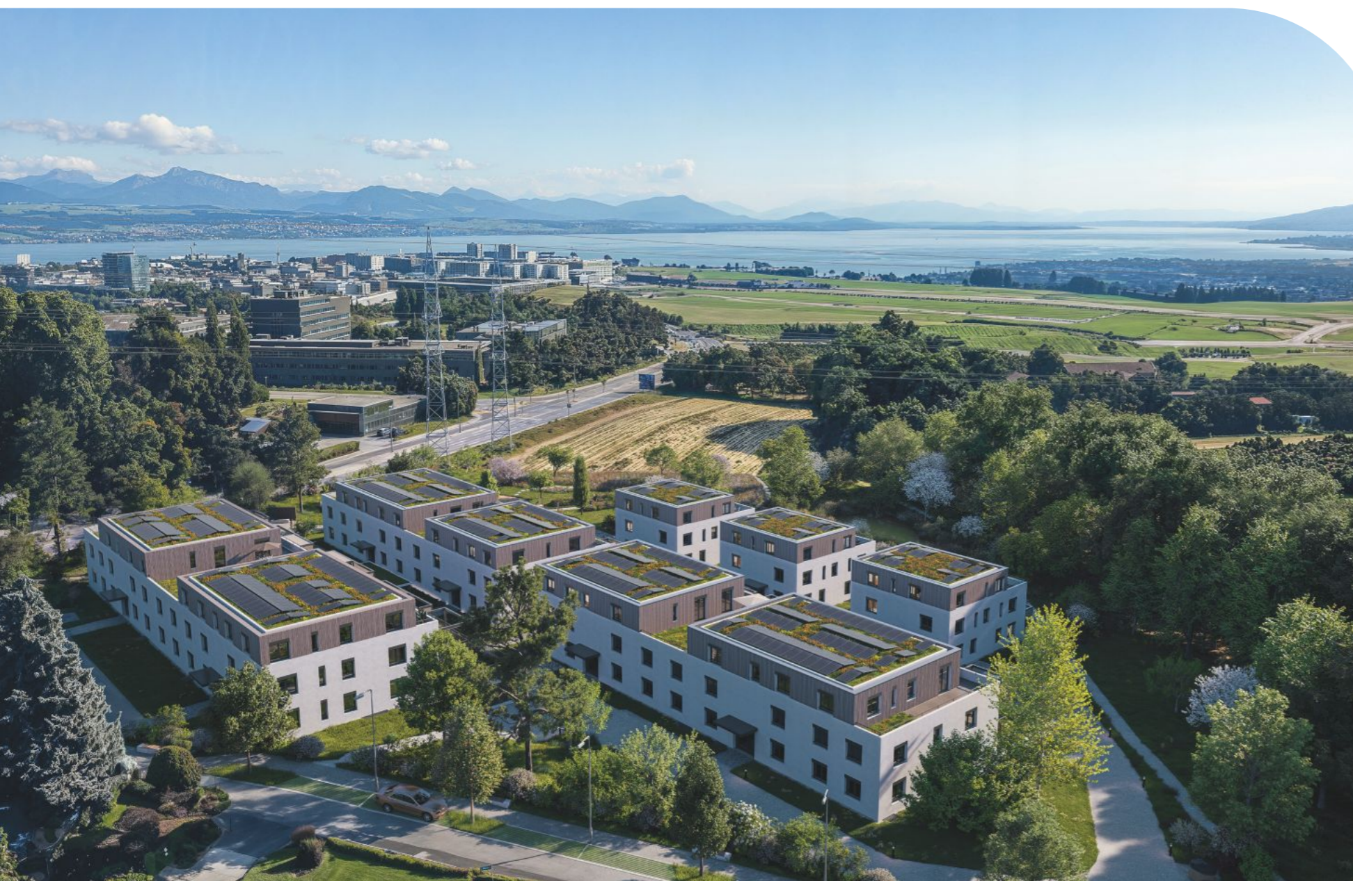
VUE AÉRIENNE DEPUIS LE NORD
